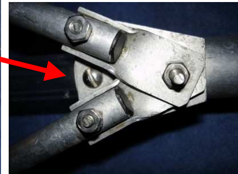
Traverses diagonales vissées à l'AVANT
