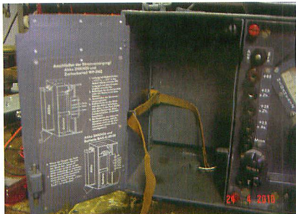
Vano survolatore e batterie
